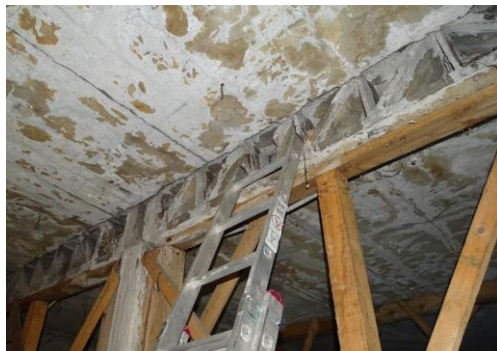
Rys. 3. Widok rzeczywistego wbudowania prefabrykatu w obiekcie (fot. W. Bereza)
