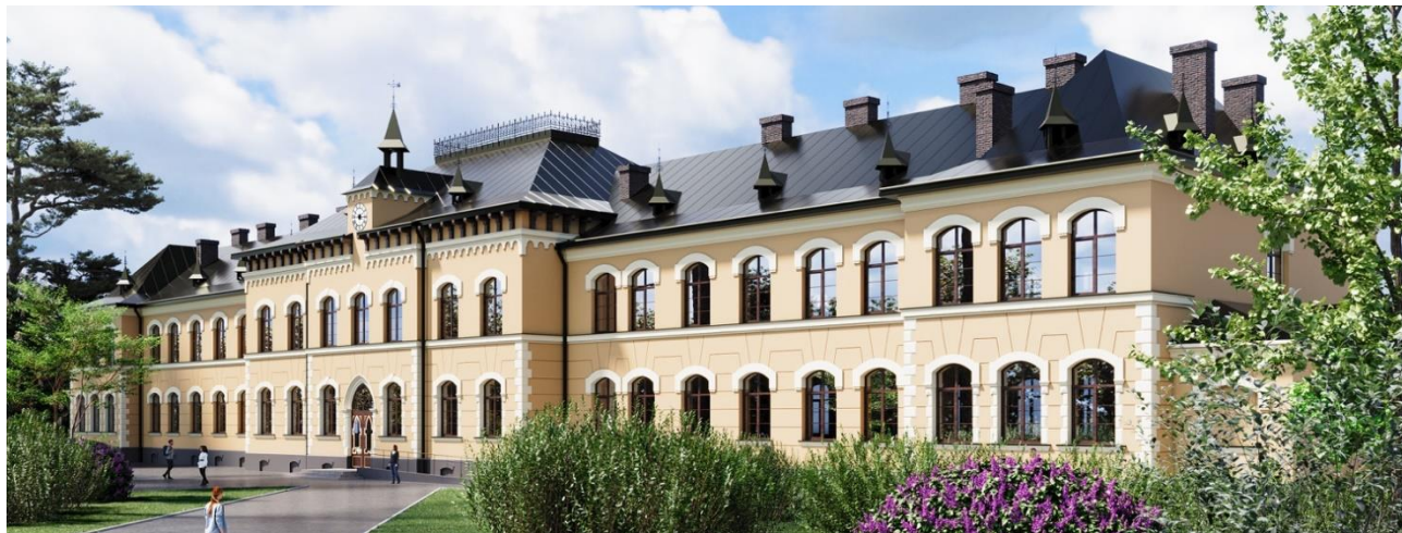
Рис. 2. Фасад відновленої будівлі навчального корпусу факультету землепорядкування та туризму
