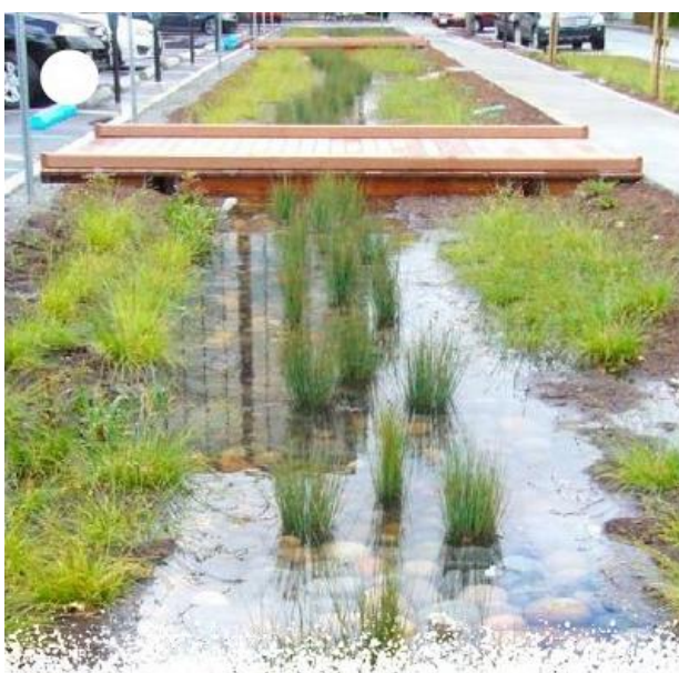
Рис.1. Дощовий сад на авеню Доннеллі в місті Берлінгейм (Каліфорнія, США) [1]
